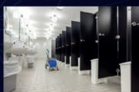
CONTROLLO DEGLI ODORI DETERGENZA
