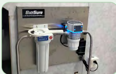
Manutenzione preventiva delle condutture dell'acqua
